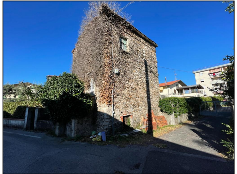
Immagini mapp. 407 – Oggetto di sostituzione edilizia
