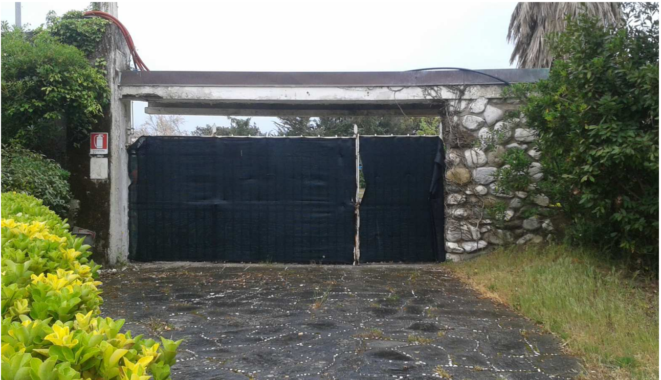
Fig. 4_ Vista dall'interno della pensilina d'ingresso sul Lungomare
