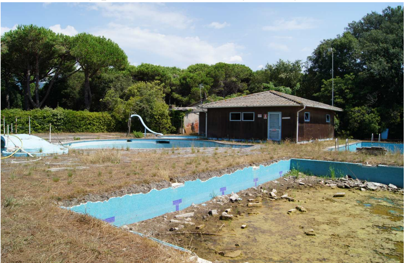
Fig. 5_ Vista delle piscine e di uno degli edifici ad uso accessorio (spogliatoi e docce)
