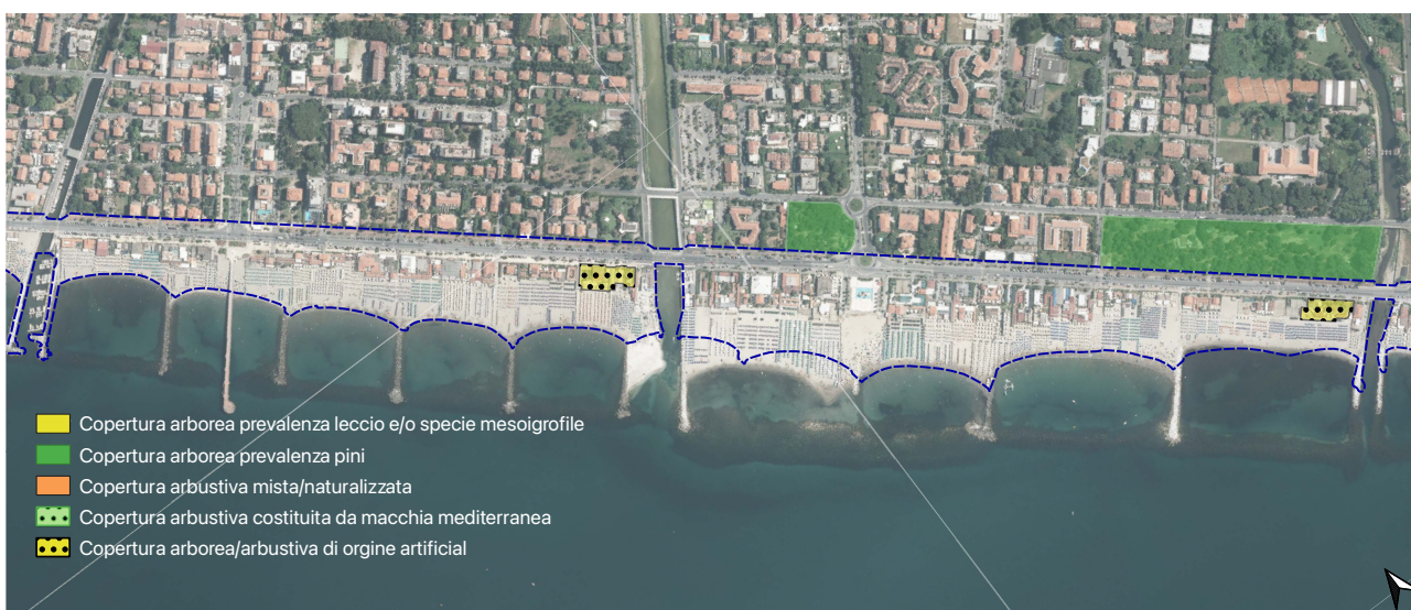
Img. 4 - Tratto via A. Vespucci e tratto iniziale Lungomare di Levante
