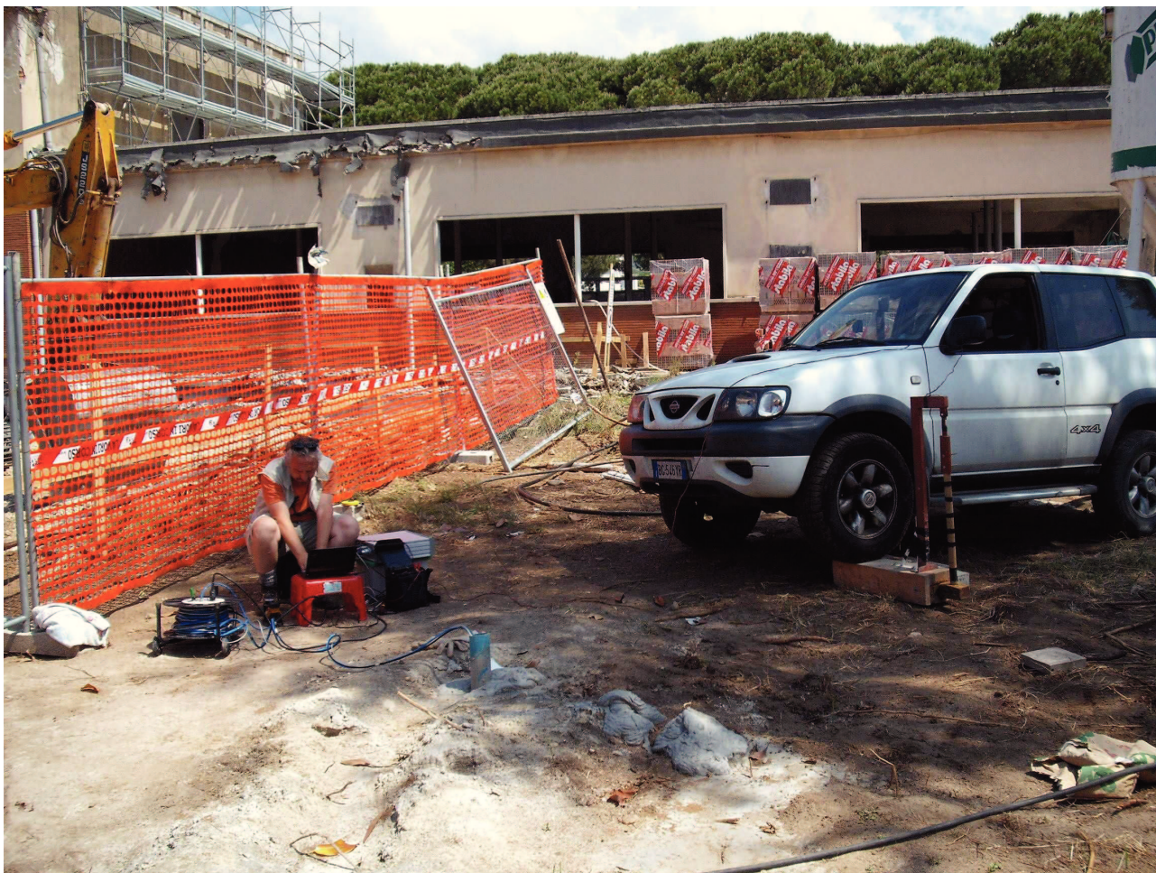
Indagine Down Hole - Documentazione fotografica.
