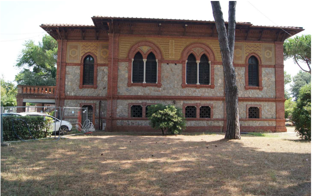
Fig. 6 _ Villa principale lato via Lucca
