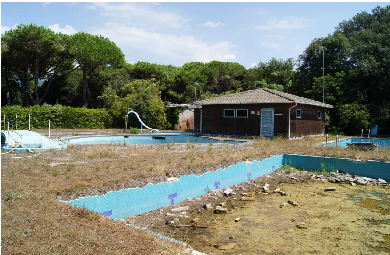
Fig. 5_ Vista delle piscine e di uno degli edifici ad uso accessorio (spogliatoi e docce)
