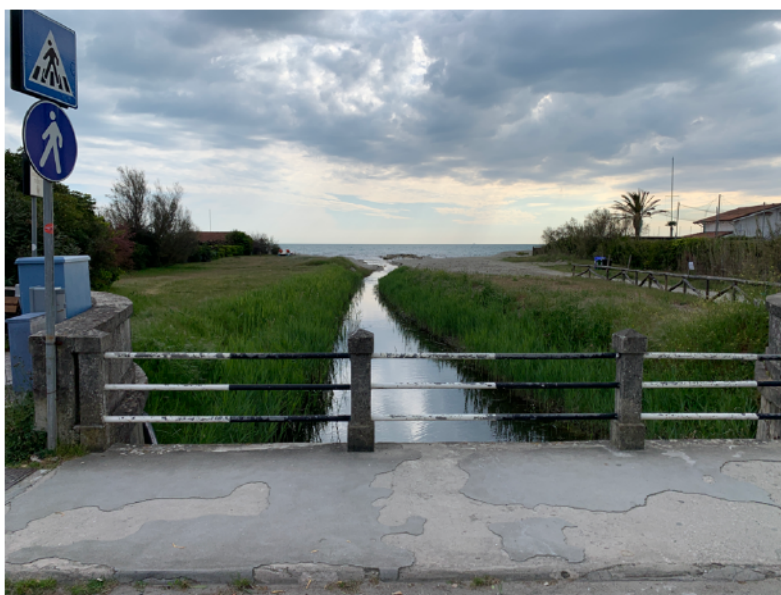
Fig. 30 - Vista del Fosso Poveromo dal ponte sul viale a mare - Esempio di Belvedere
