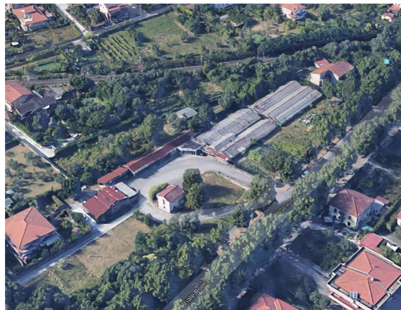
Fig.9_Veduta aerea dell'area (Fonte Google Maps ©)
