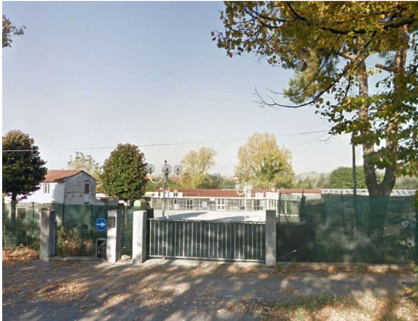
Fig.10_Vista 01 | Veduta dell'area da Viale Roma
