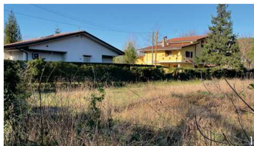
Sud-Ovest -Tipologie unifamiliari abitative, a n°2 piani fuori terra
