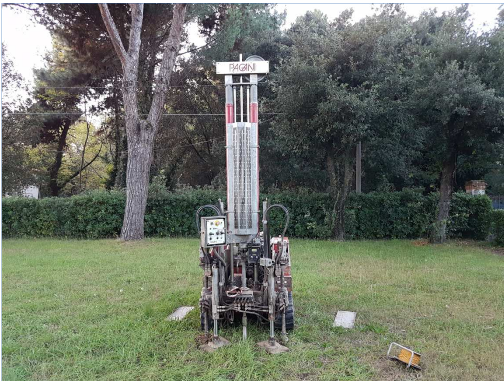
Figura 2: Prova penetrometrica CPT 2
