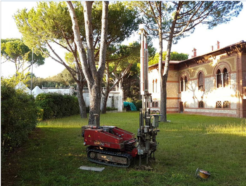
Figura 1: Prova penetrometrica CPT 1
