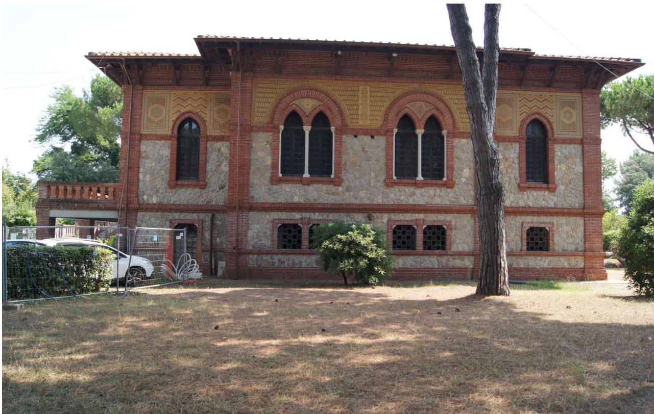
Fig. 6 _ Villa principale lato via Lucca
