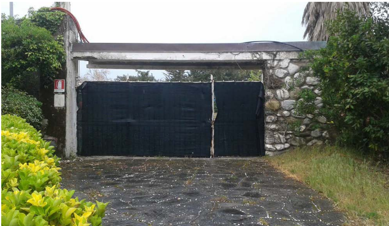
Fig. 4_ Vista dall'interno della pensilina d'ingresso sul Lungomare
