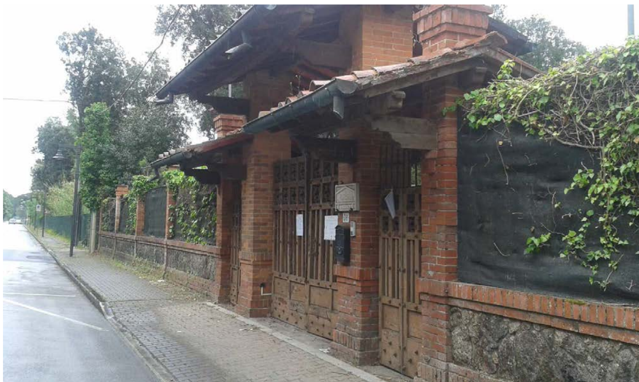
Fig. 8 _ Vista esterna dell'ingresso da via Verdi
