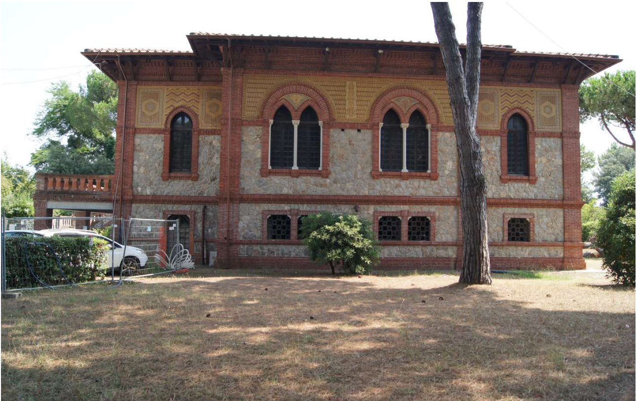
Fig. 6 _ Villa principale lato via Lucca
