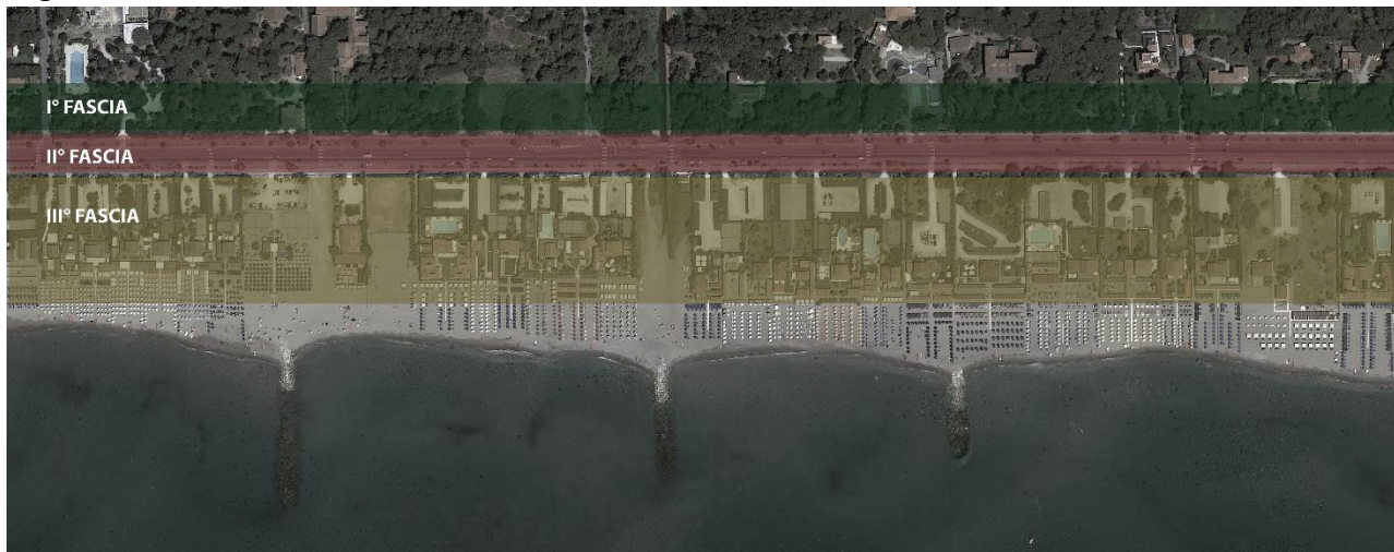
Img. 1 - Tratto di via Lungomare di Levante con indicazione delle tre fasce.
