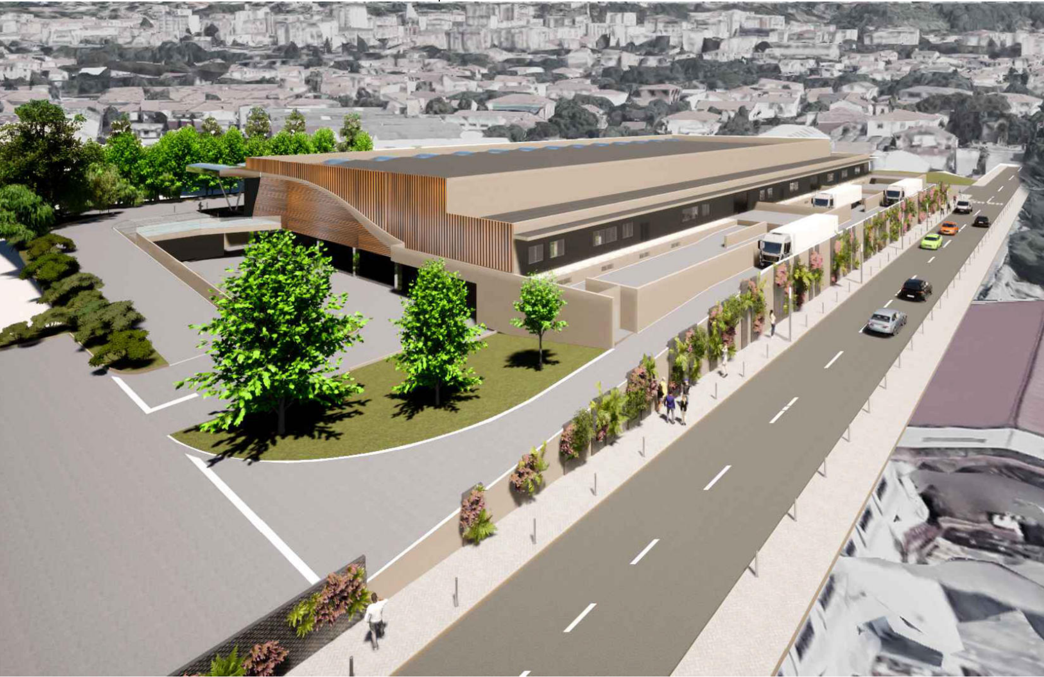
VISTA AEREA SU VIA APRILIA
