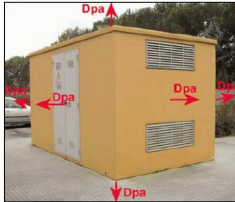
Figura 84. Esempio di distanza di prima approssimazione (dpa)
